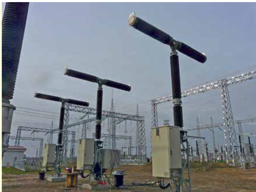
Реконструкција ТС Србобран
