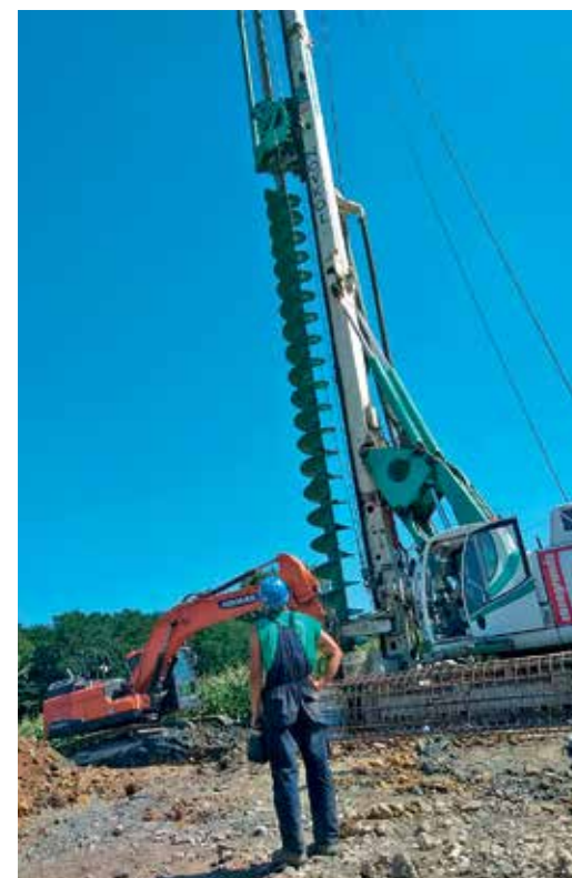
Радови на изградњи шипова
