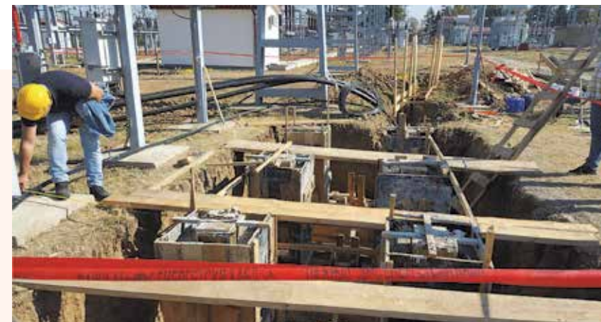
Арм. бетонски радови у оквиру трафостанице
