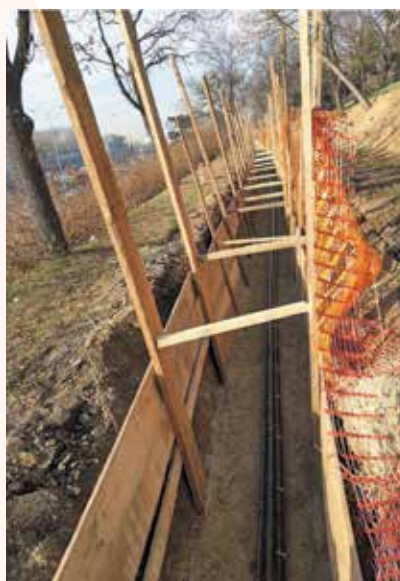
Положен кабловски вод на деоници бр. 3, КБ 110 kV ТС Београд 23 – ТС Београд 45
