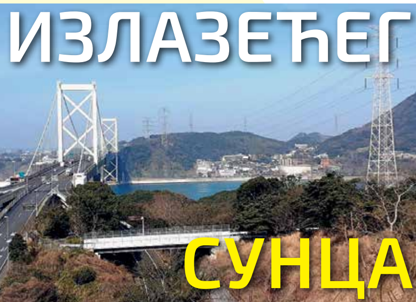
Интерконекција између острва Kyushu, односно Kyushu Electric Power Company са другим електроенергетским компанијама Јапана, једним двосистемским 500 kV надземним водом, дужине 1.200 m.
