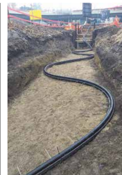
Извођење резерве испод спојнице на деоници бр. 6, КБ 110 kV ТС Београд 23 – ТС Београд 45
