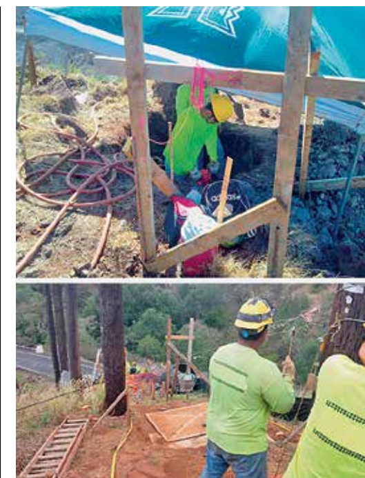
Тимови често морају ручно да копају темеље а потом да транспортују остатке са локације помоћу ручне жичаре са корпом
