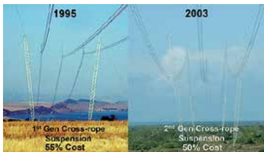
Нивои развоја стубних конструкција са изолаторским ланчаницама уместо конзола веома високог напона (ВВН) које је уградио Eskom
