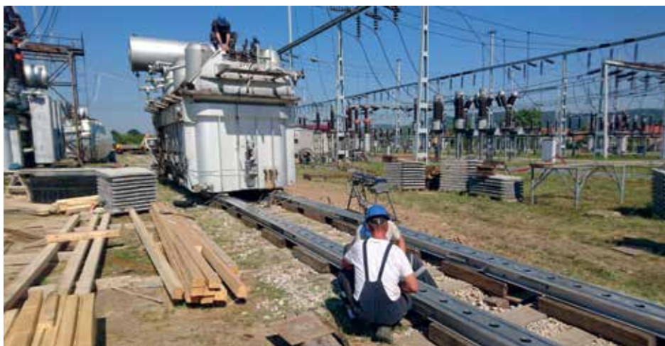
Извожење старог трафоа Т1 из постројења
