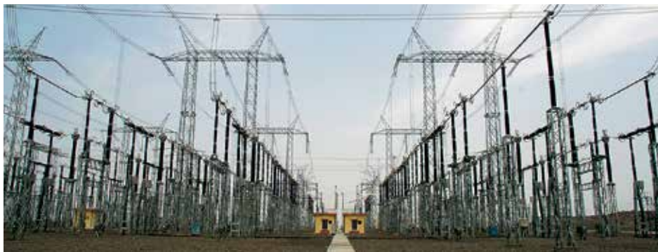
765-kV трафостаница Дуле је пројектована да прихвати седам 500MVA, 765/400-kV трансформатора и једанаест 80MVAR, 765kV пригушница.
