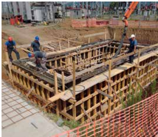
Изградња уљне јаме
