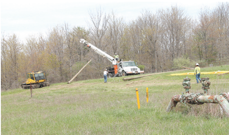
Чланови тима монтера-приправника дижу дистрибутивни стуб и проводнике на ободу шуме како би симулирали реалну штету од олује пре лета са системом LiDAR за прикупљање података у сврху развоја и испитивања ARIES-a.
