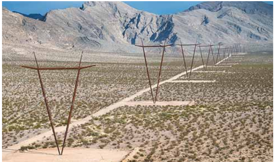
Стубови на On Line далеководу имају приметно мало површинско заузимање околине, у коју се утапа мала преформирана бетонска основа и четири анкера за затеге
