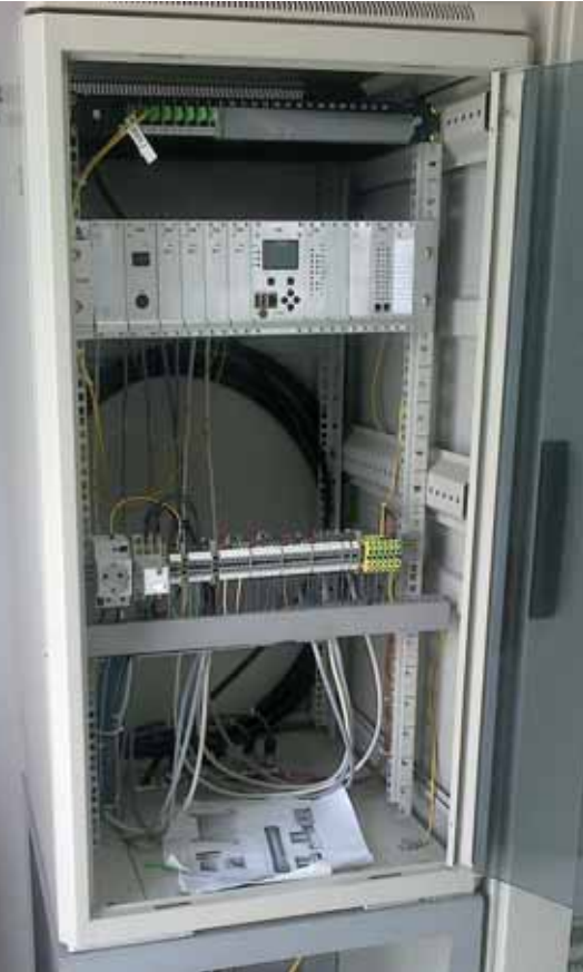
Уређај за пренос сигнала на други крај вода у фази монтаже
