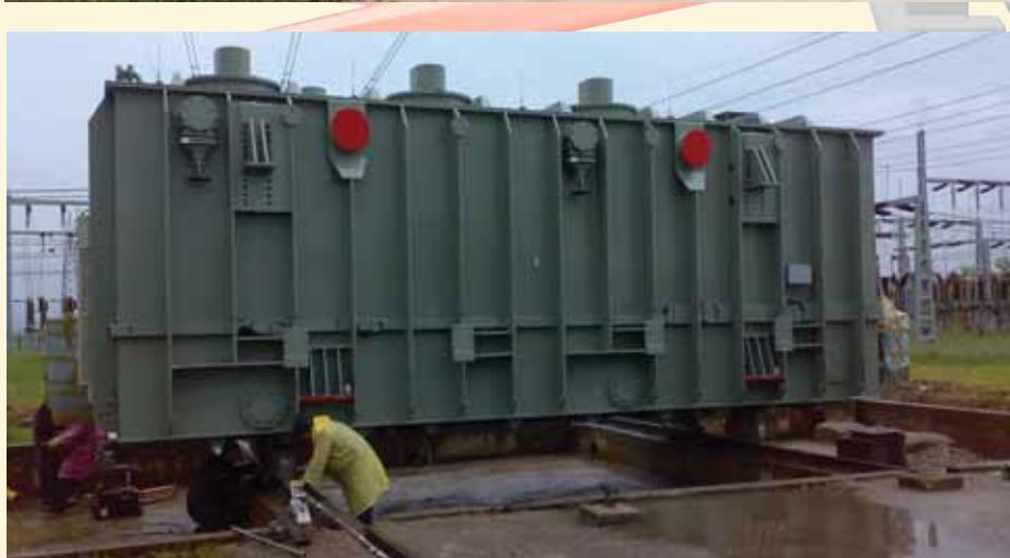
**Н**а ТС 400/ 110 kV Крагујевац 2 ових дана обављају се монтажни и електромонтажни радови на замени једног трансформатора инсталисане снаге 300 мегаволтампера. Трансформатор је знатно старије генерације и Кончареве производње. На њего-во место монтира се нови трансформатор исте инсталисане снаге и истог произвођача.
