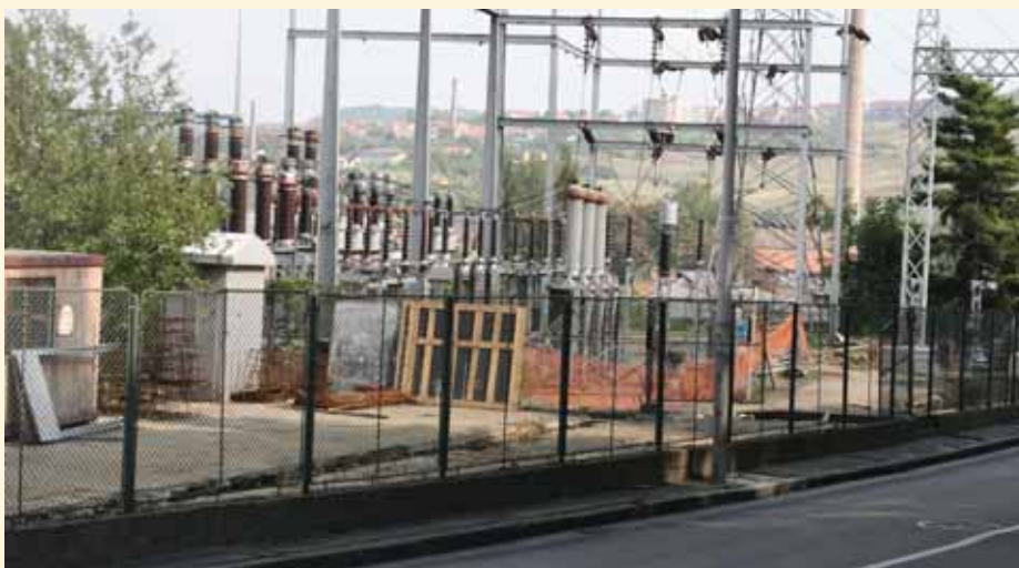
Реконструкција Трафостанице Београд 1
