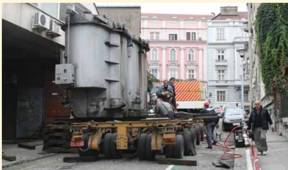
Обнављање ТС Београд 6
