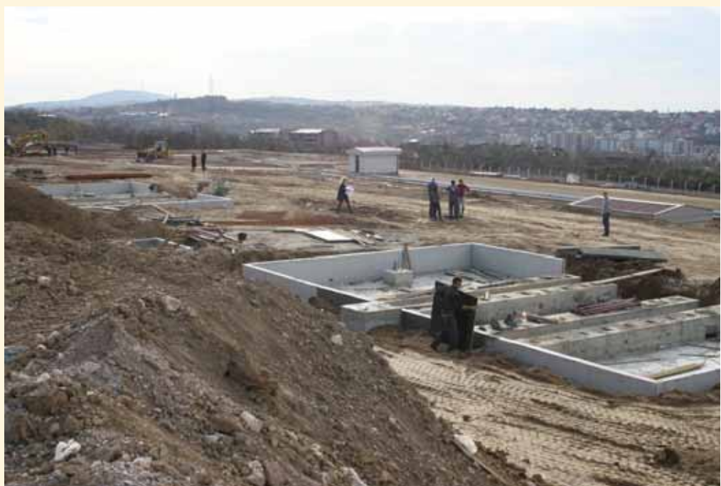
Градилиште ТС Београд-20
