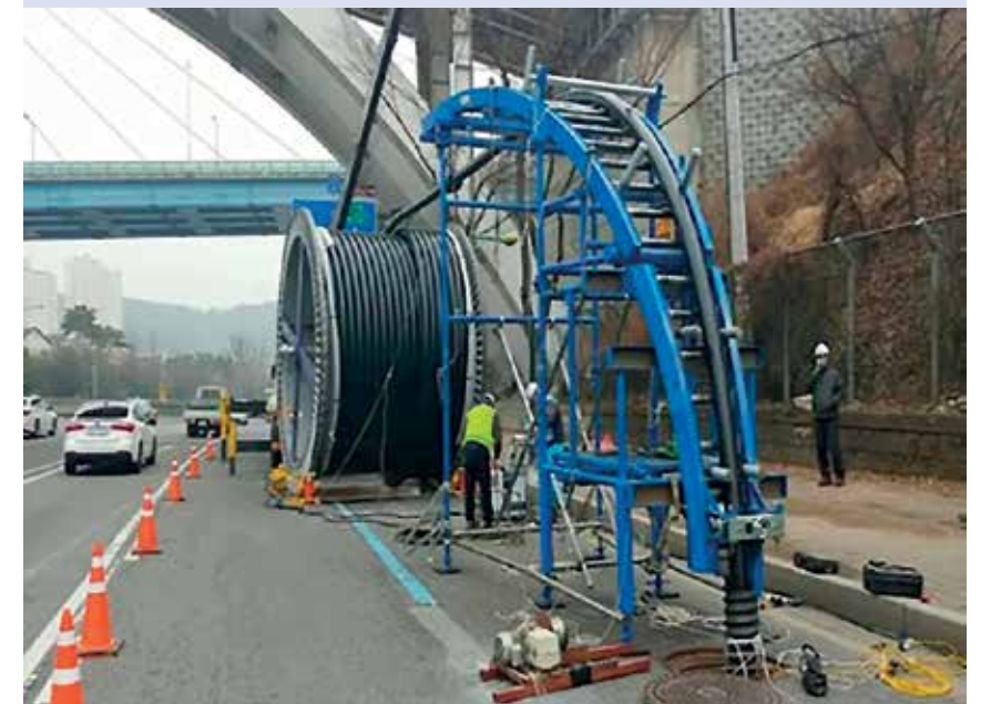
Радови на постављању кабла
